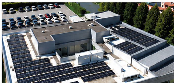
Nuovo impianto fotovoltaico sede di una banca
