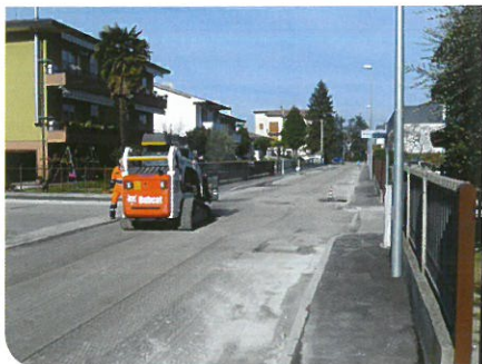
Preparazione asfaltature via Buonarroti
