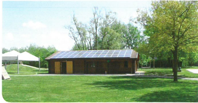
2008-2009 - Parco Bapi - Allestimento bar e installazione giochi - € 50.000 2011 - Realizzazione impianto fotovoltaico c/o casetta in legno del Parco Bapi - potenza 17,64 kWp - € 67.000
