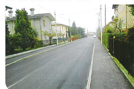
2009-2010 - Rifacimento marciapiedi comunali con abbattimento barriere architettoniche - via L. Da Vinci - via Buonarrotti - via Carducci - via Zanella - via M. Polo - € 128.000
