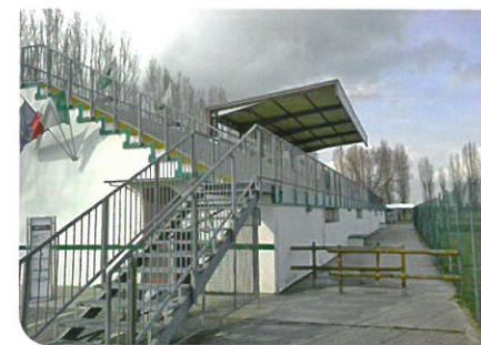
2011 - Rifacimento/adeguamento impianto elettrico, tinteggiatura locali, rifacimento fognature acque nere, c/o spogliatoi impianti sportivi/campi da calcio Mestrino - € 30.000
