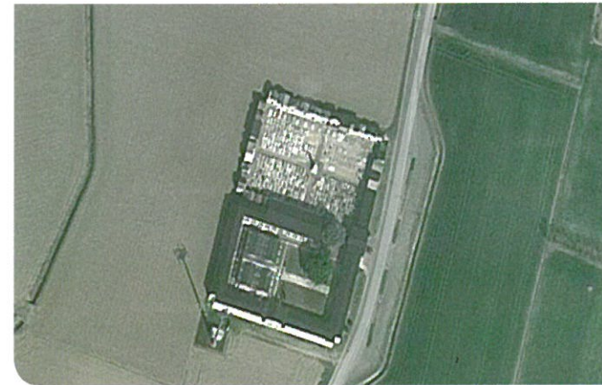
2011-2012 - Sostituzione copertura cimitero di Mestrino - € 43.000
