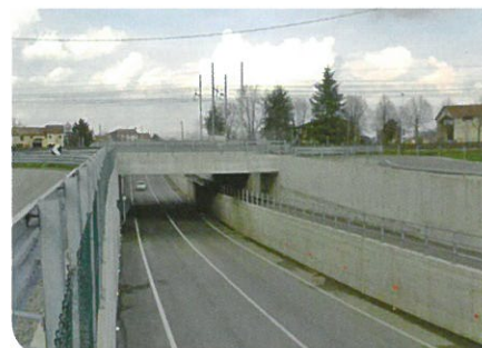
2010 - Nuovi impianti di illuminazione stradale - via Monte Cengio - sottopasso ferroviario Lissaro e incroci - € 30.000
