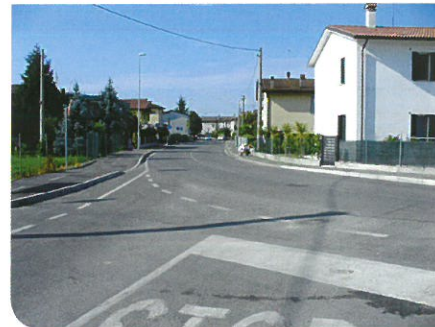
Via Martignon incrocio via Carso
