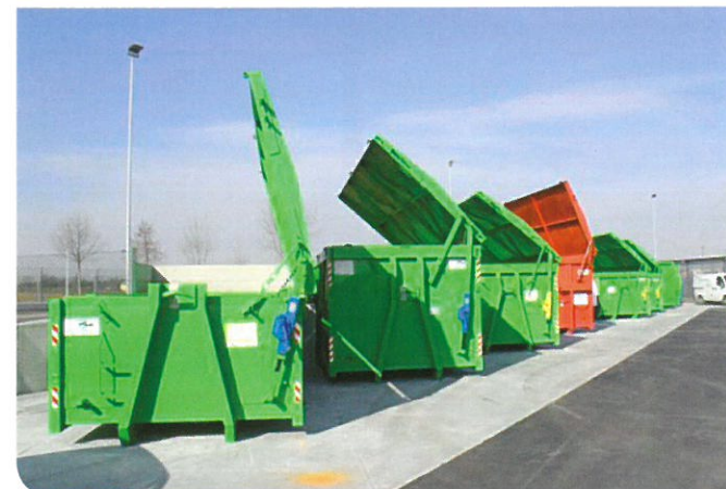
2011 - Realizzazione nuovo centro di raccolta dei rifiuti comunale, via Petrarca - realizzato da Etra S.p.A.
