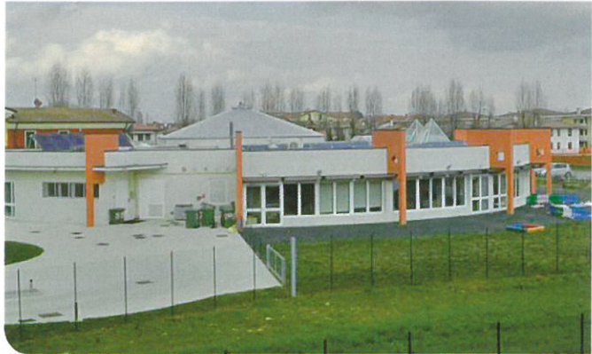
2011 - Realizzazione impianto fotovoltaico c/o Scuola materna/centro d'infanzia - potenza 9,0 kWp - € 60.000
