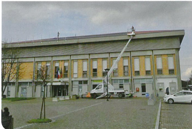
2012-2013 - Rifacimento copertura sede municipale - € 110.000
