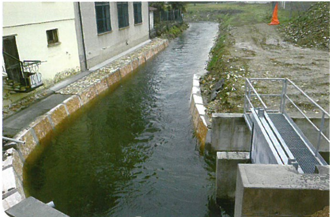
2012 - Rifacimento scolmatore Fiume Ceresone Arlesega (in ambito esecuzione centralina idroelettrica su Fiume Ceresone) - Realizzato dal Consorzio Brenta
