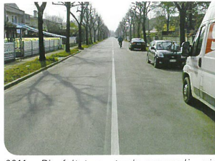
2011 - Riasfaltatura strade comunali - via Trieste - via Milano - via Toscanini - via Montegrappa - via L. Da Vinci - € 135.000
