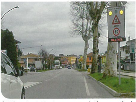
2012 - Installazione segnaletica verticale luminosa su attraversamenti pedonali lungo S.R.11 - € 15.000
