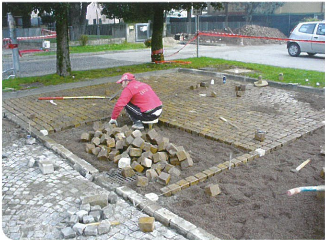
2013 - Rifacimento pavimentazione in porfido parcheggi comunali piazza IV Novembre - € 55.000
