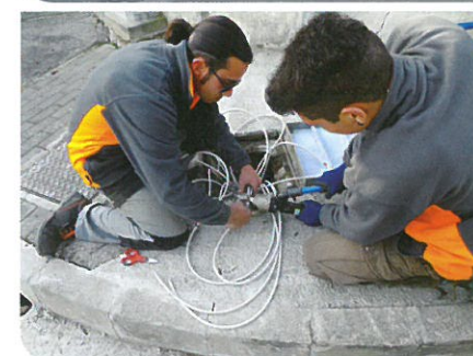
Lavori nuovi impianti pubblica illuminazione
