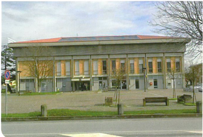
2012 - Realizzazione impianto fotovoltaico c/o municipio - potenza 19,25 kWp - realizzato da Etra S.p.A.
