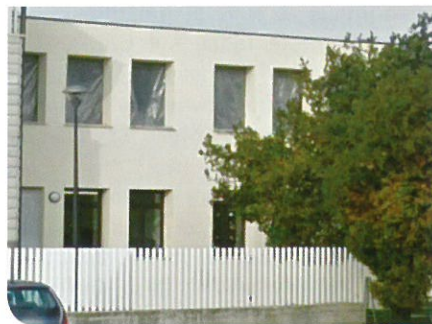
2013 (in fase di appalto) - Ampliamento Scuola Elementare "De Amicis" di Lissaro, 2° stralcio completamento aule piano superiore - € 200.000
