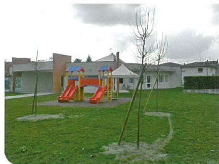
2009-2010 - Costruzione nuova Scuola Materna di Mestrino (poi alienata) - ora Centro d'Infanzia - € 1.270.000
