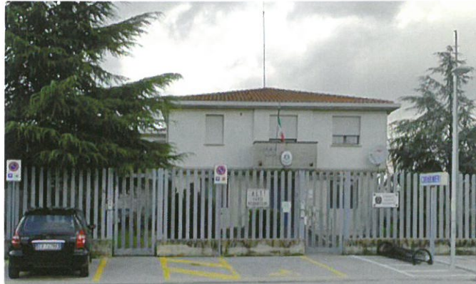
2012 - Rifacimento impianto elettrico caserma carabinieri - € 10.000
