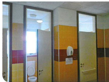
2008 - Ristrutturazione bagni Scuola Media di Mestrino - € 160.000
