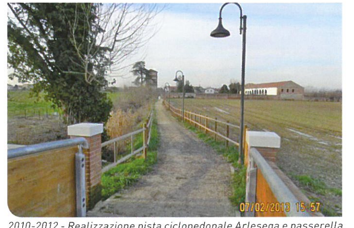
2010-2012 - Realizzazione pista ciclopedonale Arlesega e passerella sul fiume Ceresone (in ambito opere di estensione fognatura via Fusinato) - realizzato da Etra S.p.A.
