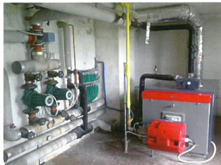
2011-2012 - Adeguamento impianto elettrico e idraulico centrale termica Scuola Elementare "Don Bosco" di Mestrino - € 10.000
