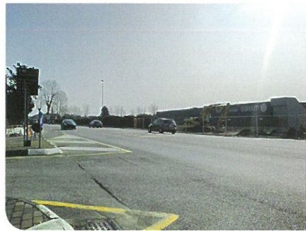
2013 (in corso) - Nuova rotonda incrocio S.R.11/via Tevere/via Caldonazzo - € 950.000 (cofinanziamento € 200.000 Regione e € 100.000 Provinciale)
