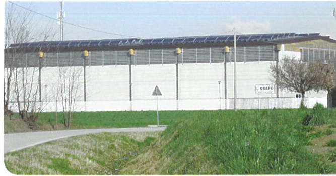
2010 - Realizzazione impianto fotovoltaico c/o palestra comunale e Scuola di Lissaro - n. 2 impianti potenza 19,80 kWp - realizzato da Etra S.p.A.
