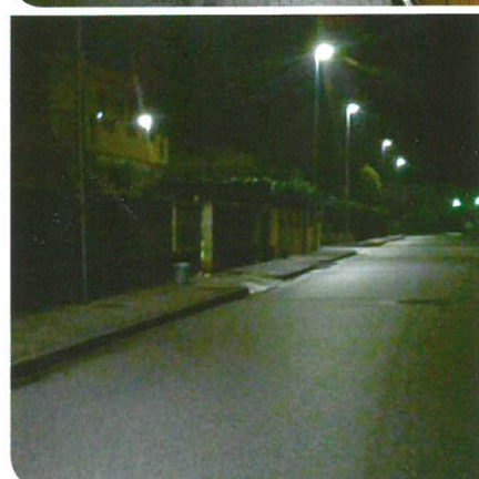
2012 - Rifacimento e adeguamento impianti di illuminazione stradale LED - via De Gasperi - via Calatafimi - via Trento - via El Alamein - via Trieste - via S. Antonio - via Pio XII - (in programma altre vie) - € 240.000
