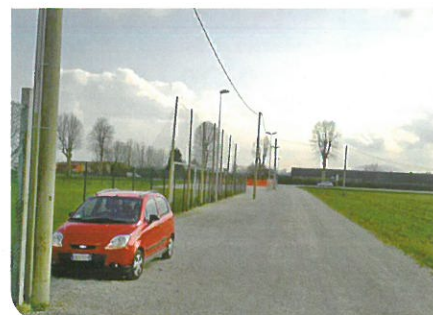
2011-2012 - Nuovo impianto di illuminazione tratto di strada/accesso da via Galilei/S.R.11, agli impianti sportivi/campi calcio di Mestrino - € 5.000
