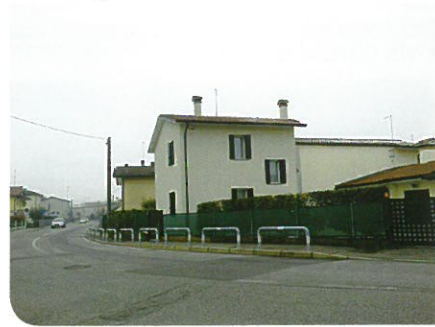
Nuovi archetti parapetonali via Martignon
